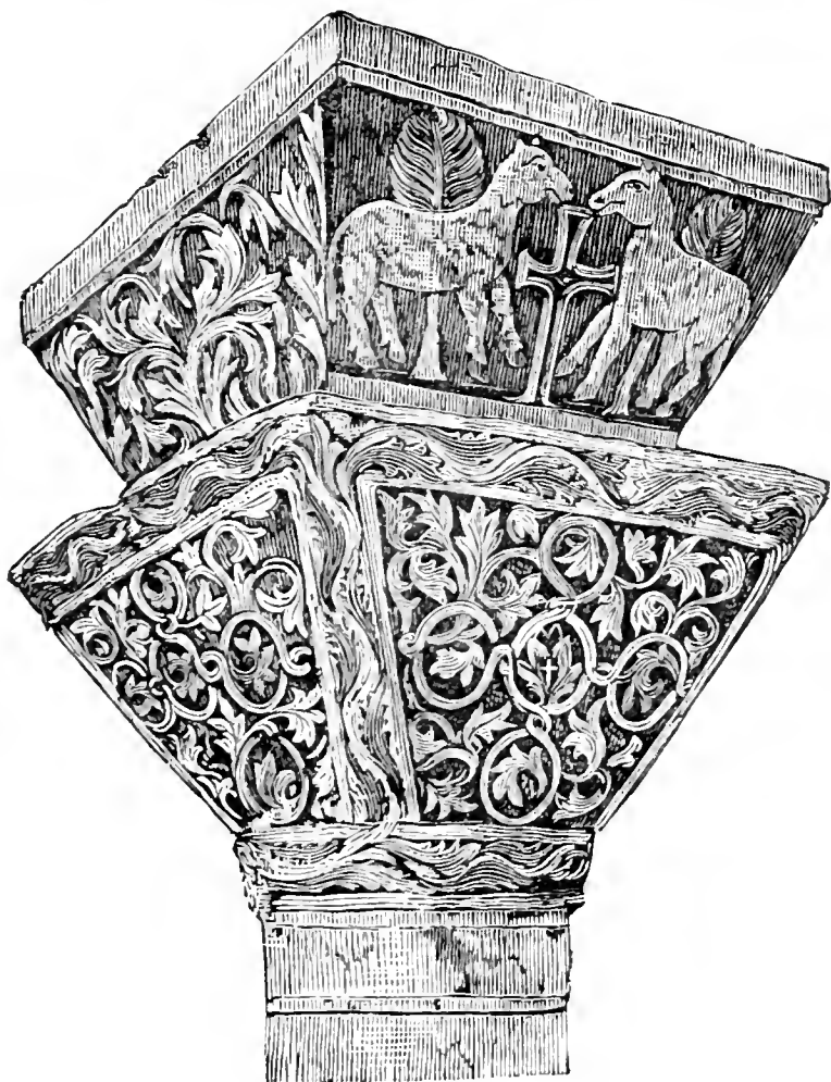
Chapiteau à l'église de Saint-Vital, à Ravenne.
